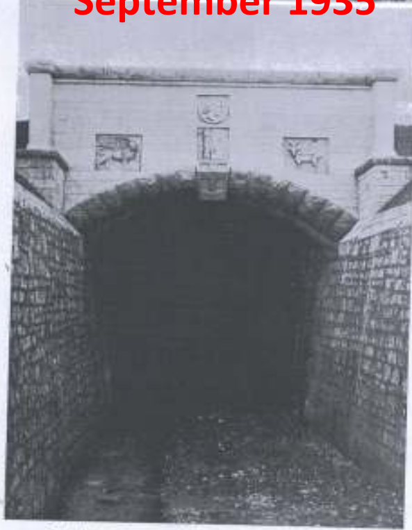
Portale d'imboccatura della galleria prima dello scarico
